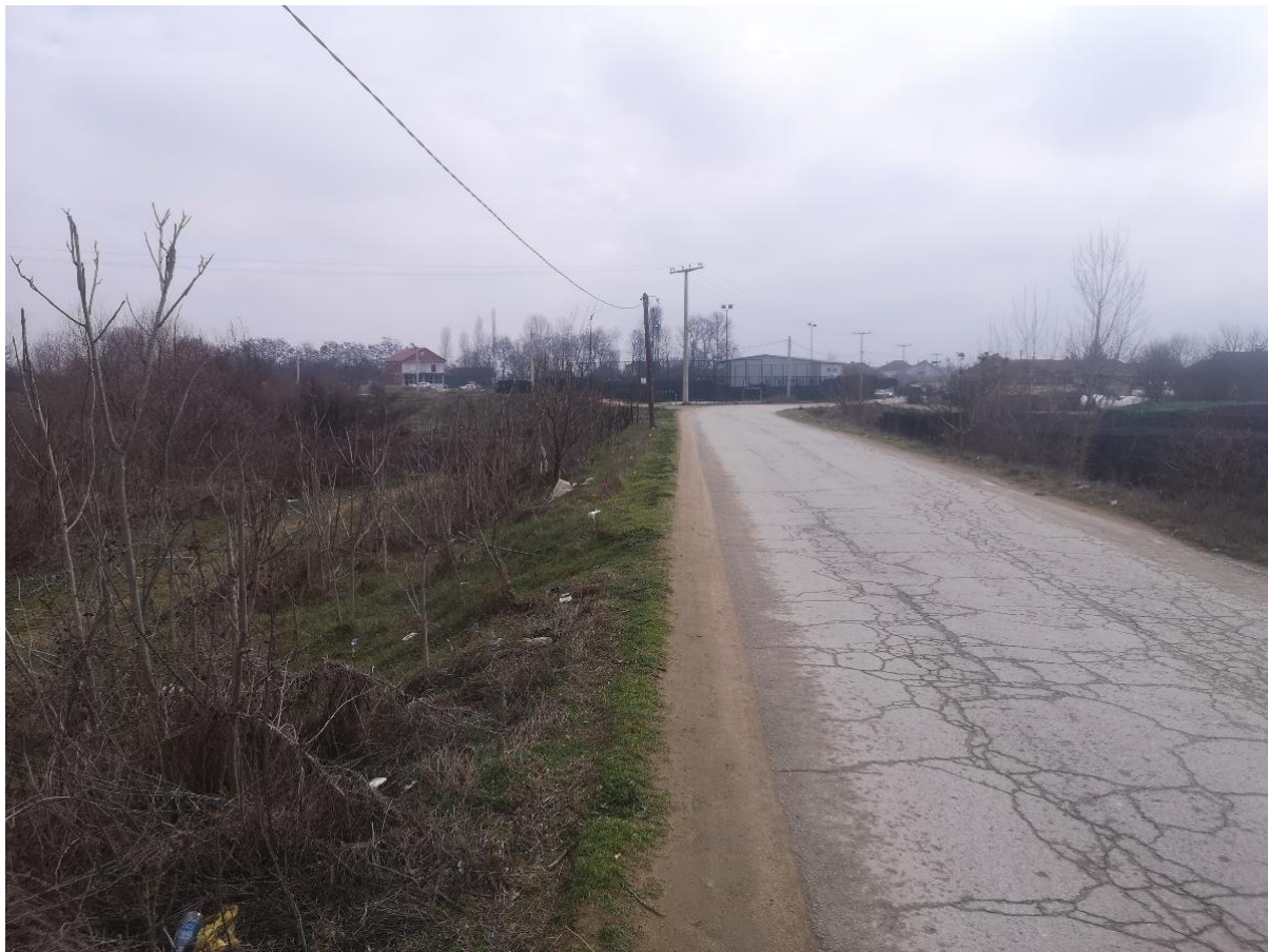
Слика 1 Постоечка состојба – асфалтен коловоз на влез во с. Еднокуќево
