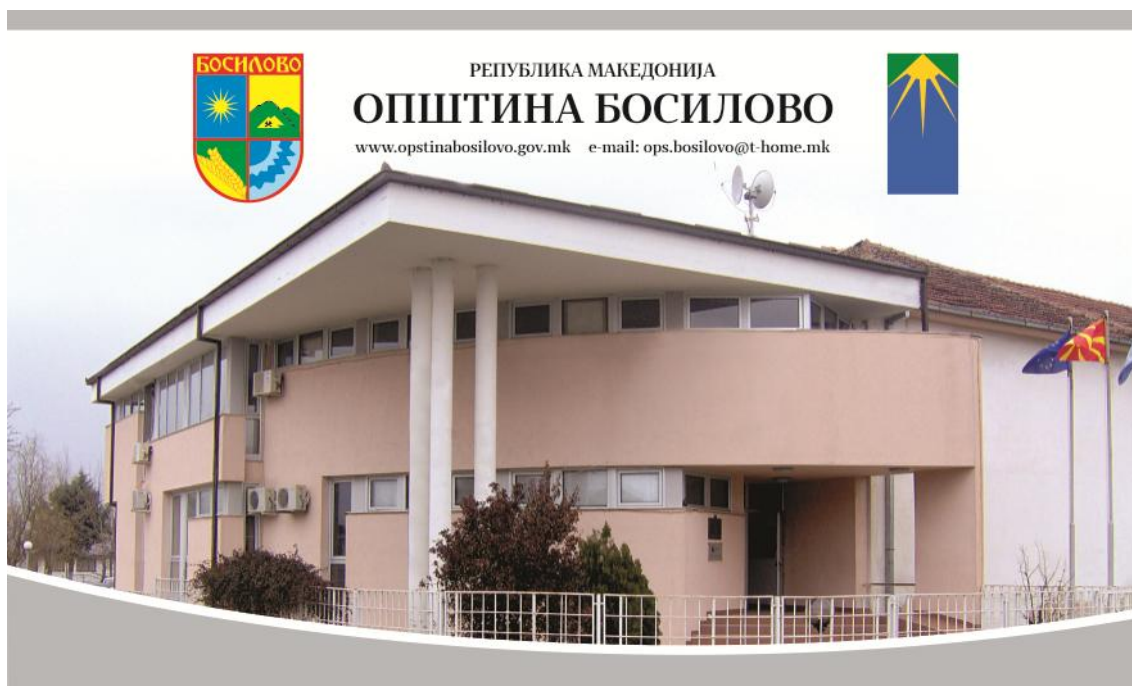
Слика бр. 1: Зграда на општина Босилово
