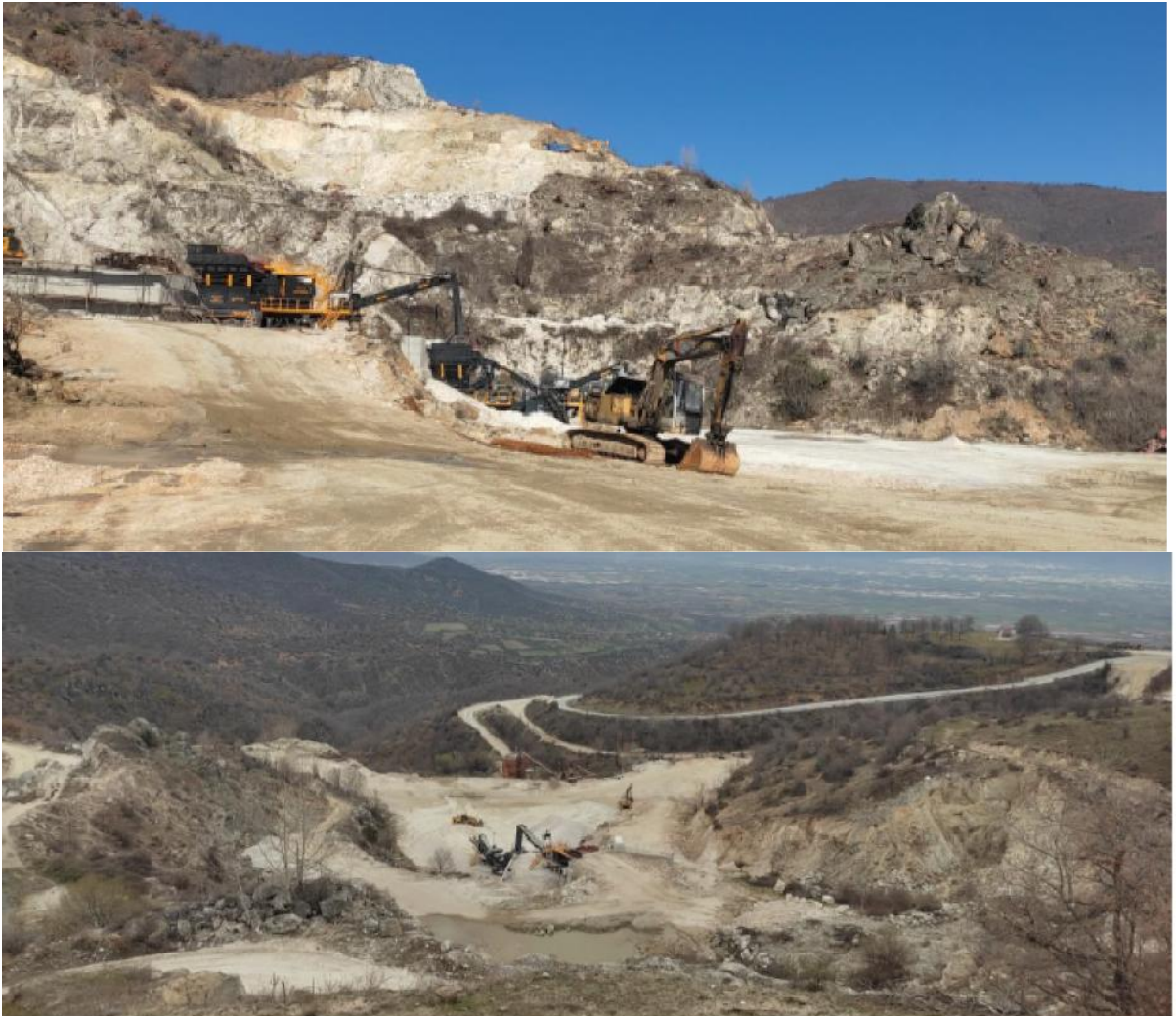
Слика бр. 20 АД за неметали „Огражден“ Струмица
