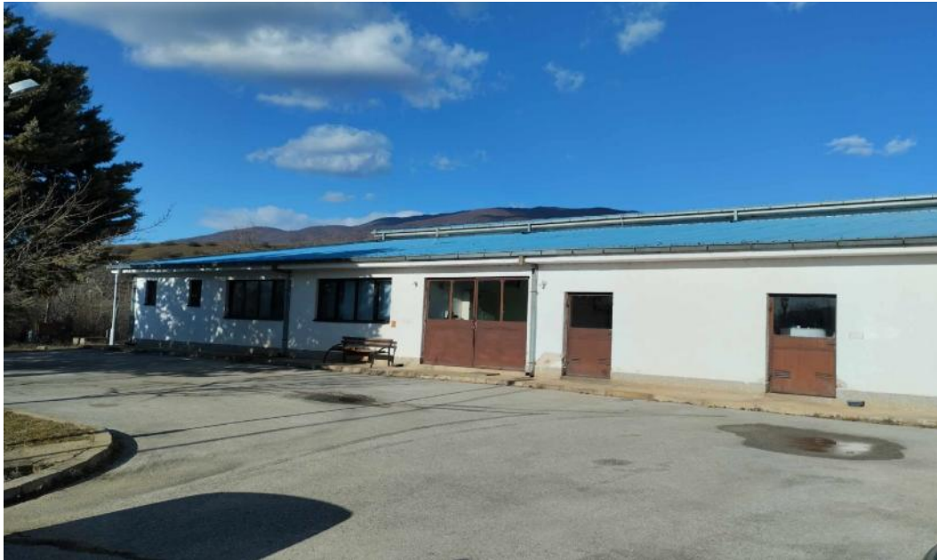
Слика бр.13 Филтер станица - регионален водовод „Иловица“
