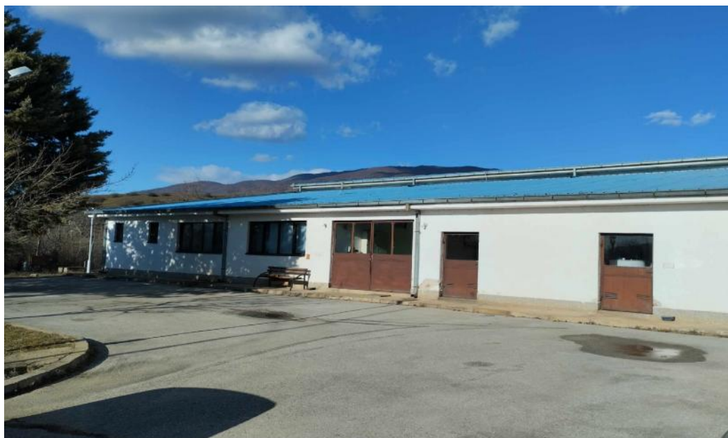
Слика бр.13 Филтер станица - регионален водовод "Иловица"
