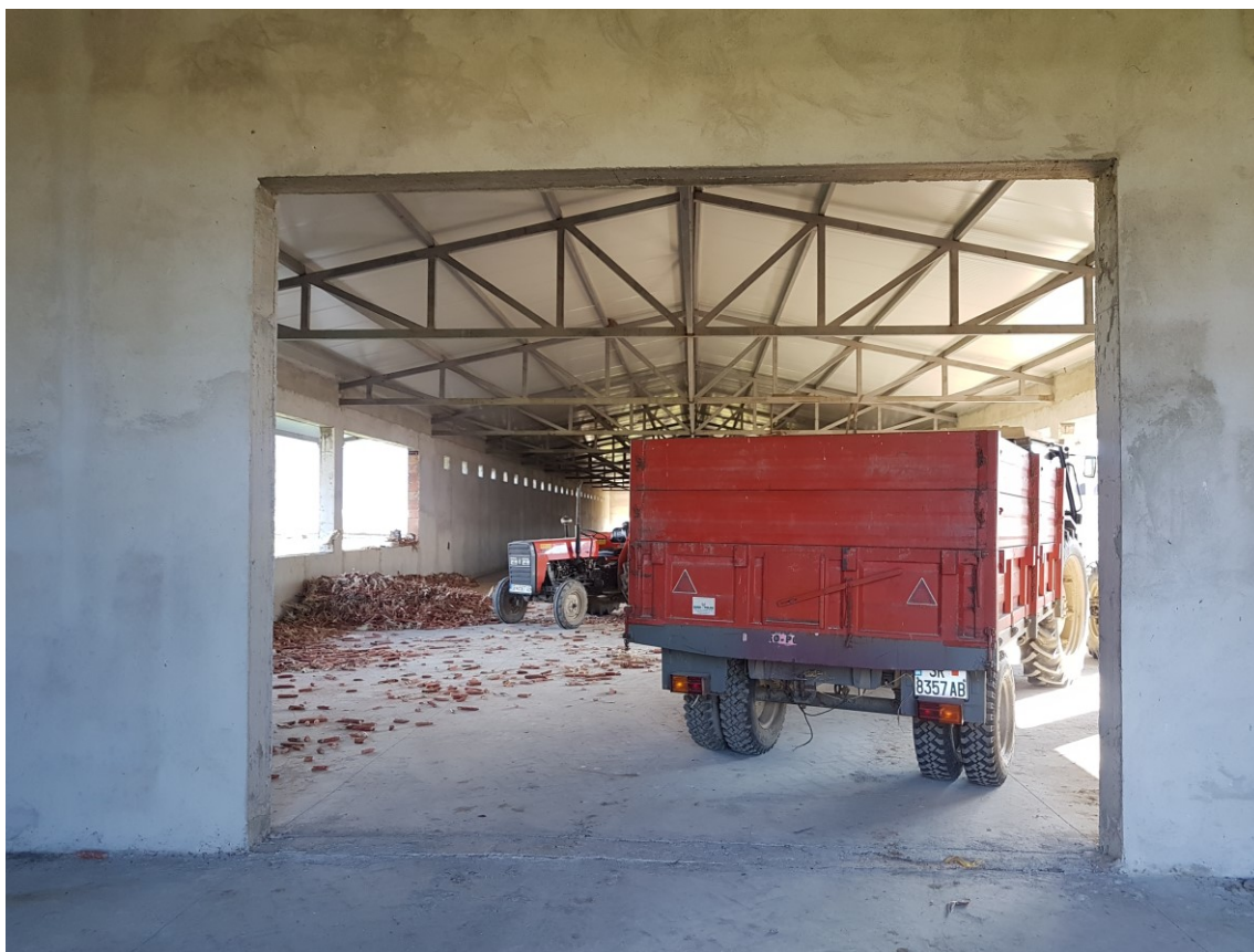
Објект бр 3 за несилки – во фаза на подготовка за почеток на дејност
