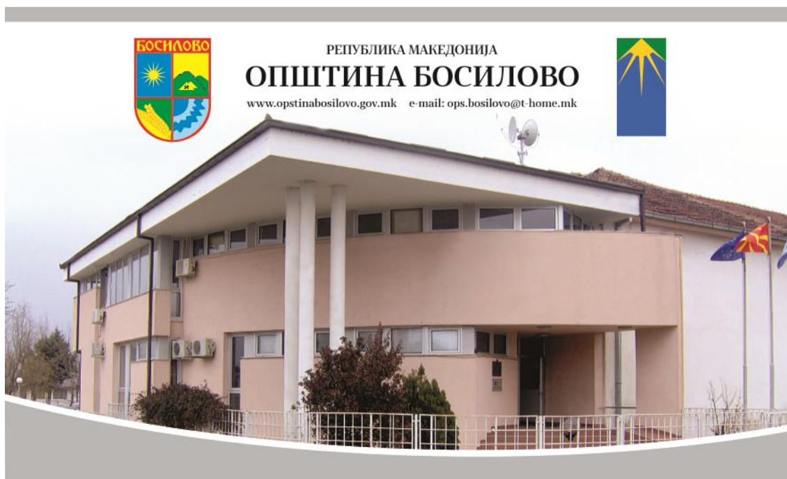
Слика бр. 1: Зграда на општина Босилово
